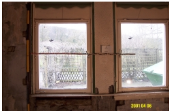
Abbildung 12 Ausmauerung – Ziegel, Putze
